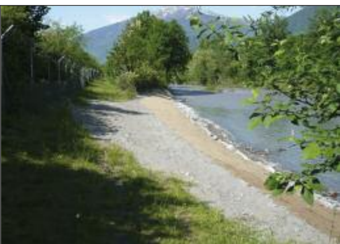
Zone d'érosion après travaux provisoires (mai 2009).
